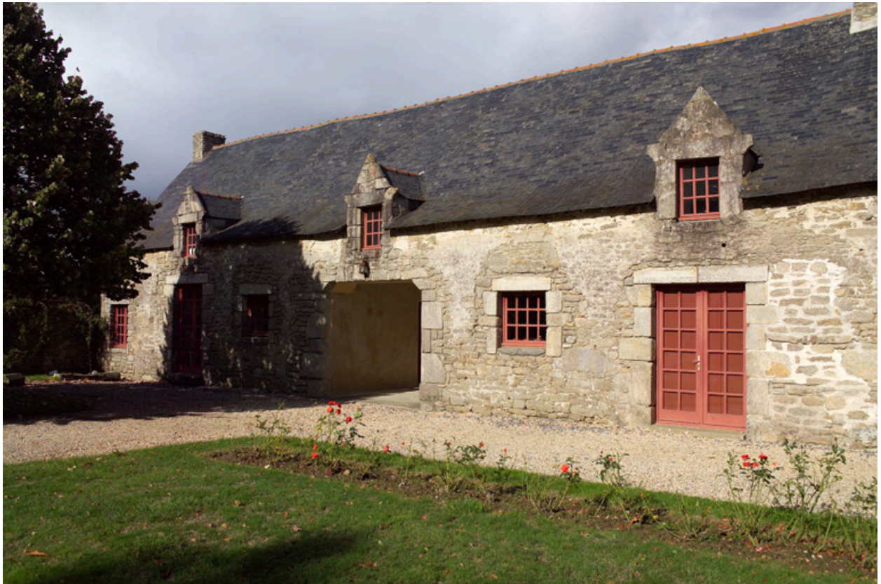
Élévation gauche du premier corps de communs.
