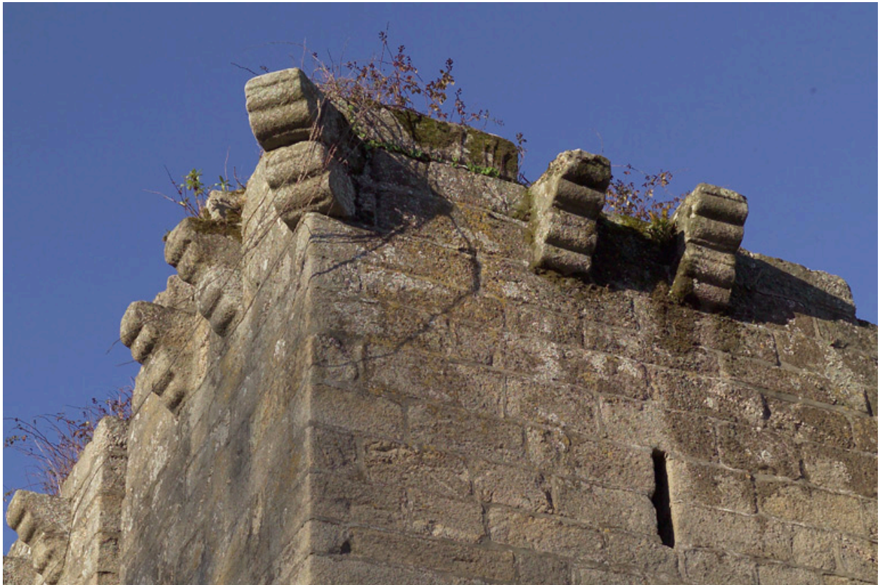
Détail des console au sommet de l'élévation côté campagne.
