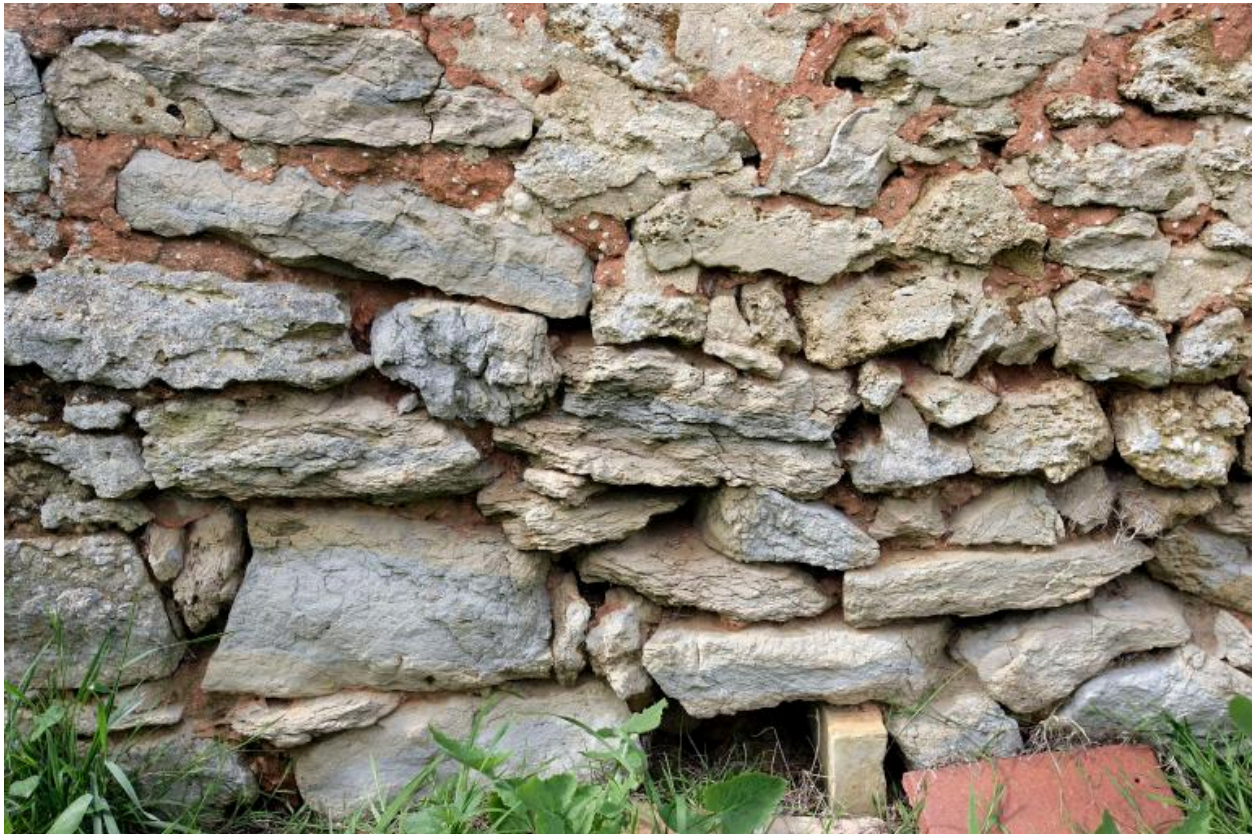
Étables, élévation postérieure : détail de la maçonnerie en moellons de calcaire.
