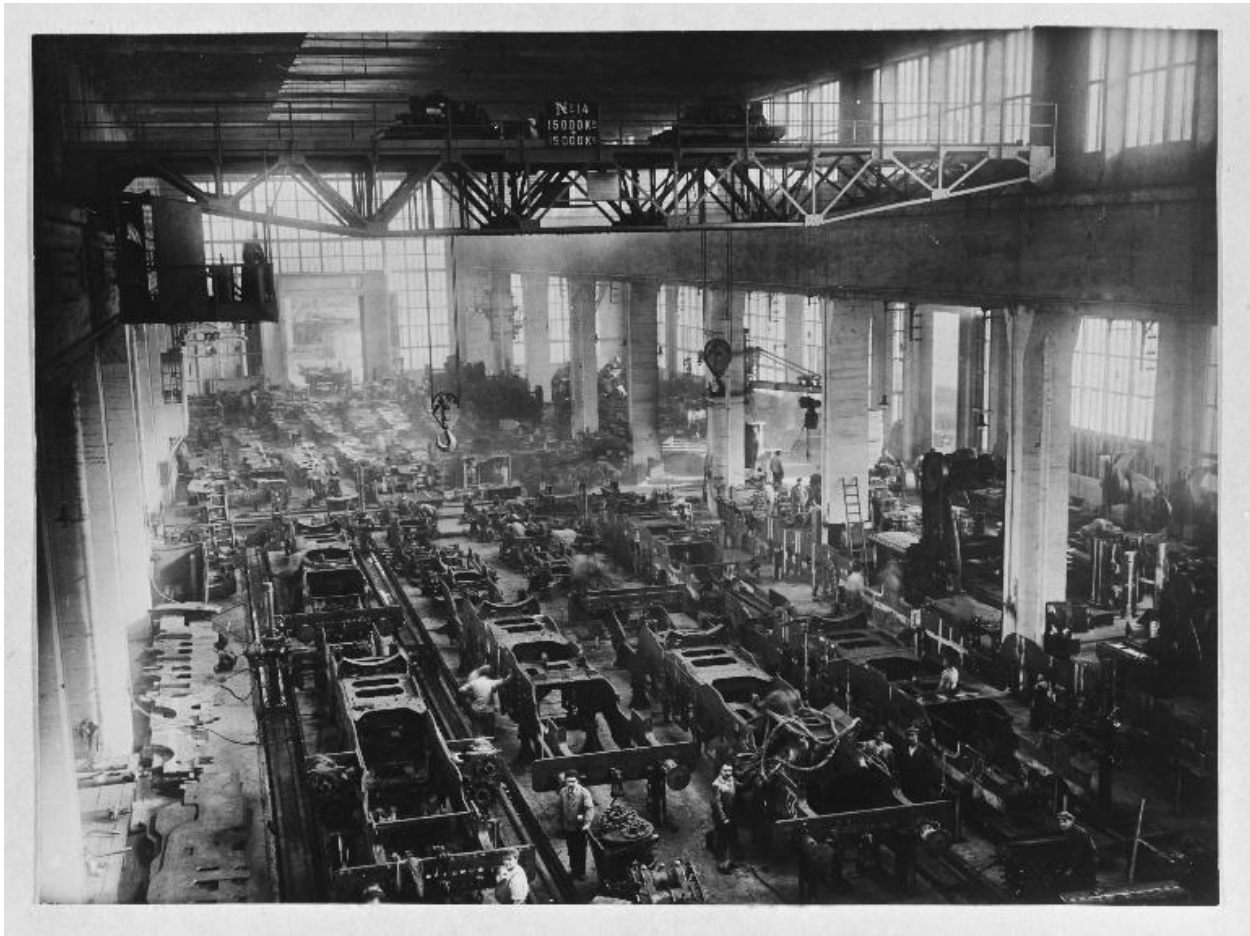
Atelier E : montage des châssis, 1921.
