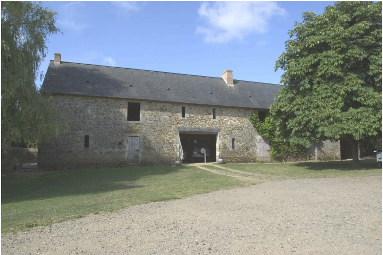
La façade principale de l'étable à chevaux-fournil vue depuis le nord-est.
