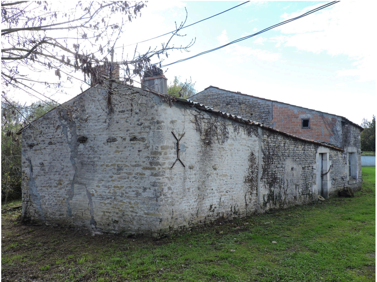
Le logis vu depuis le nord-est.
