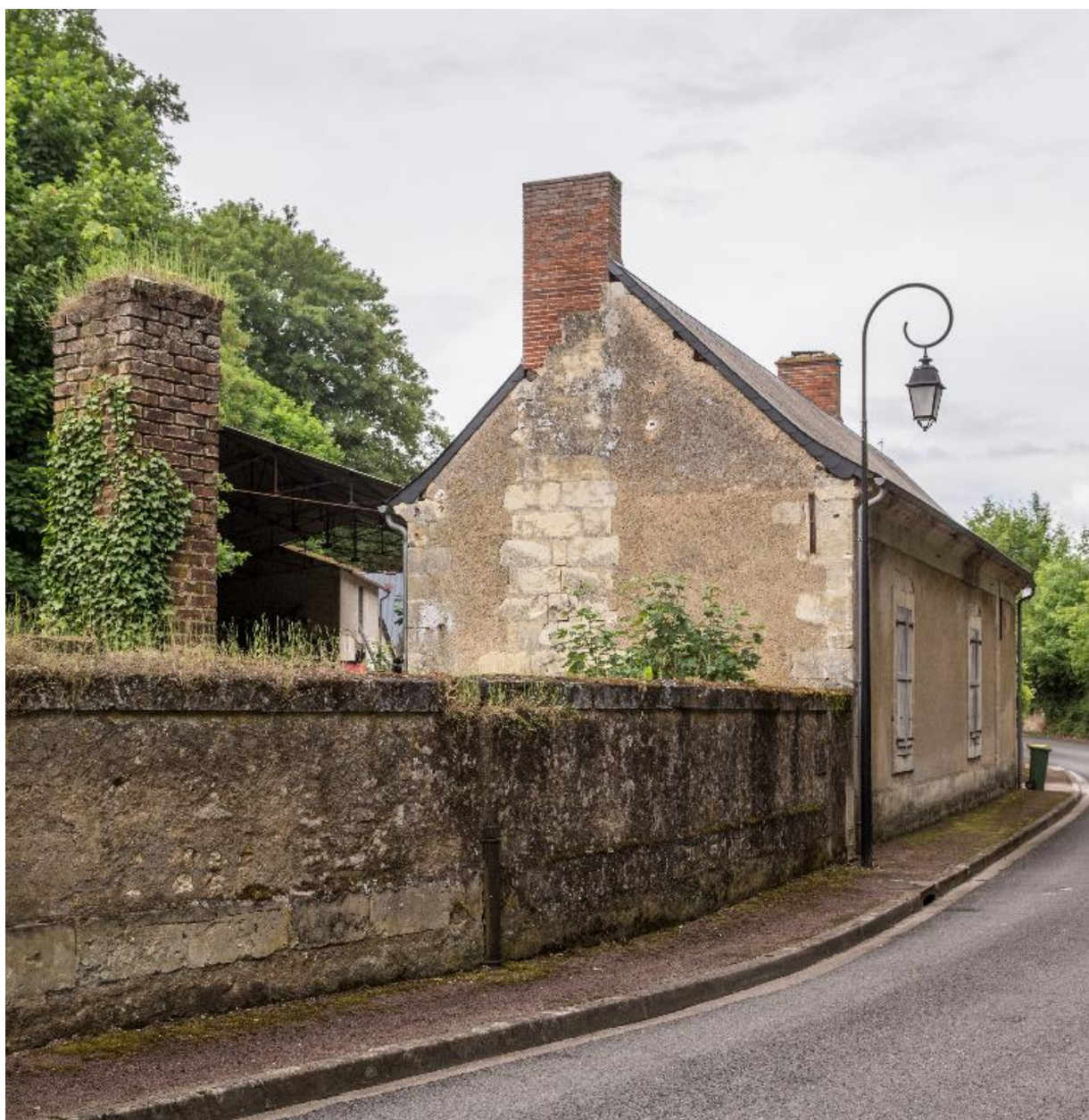
Logement, vu depuis la rue.
