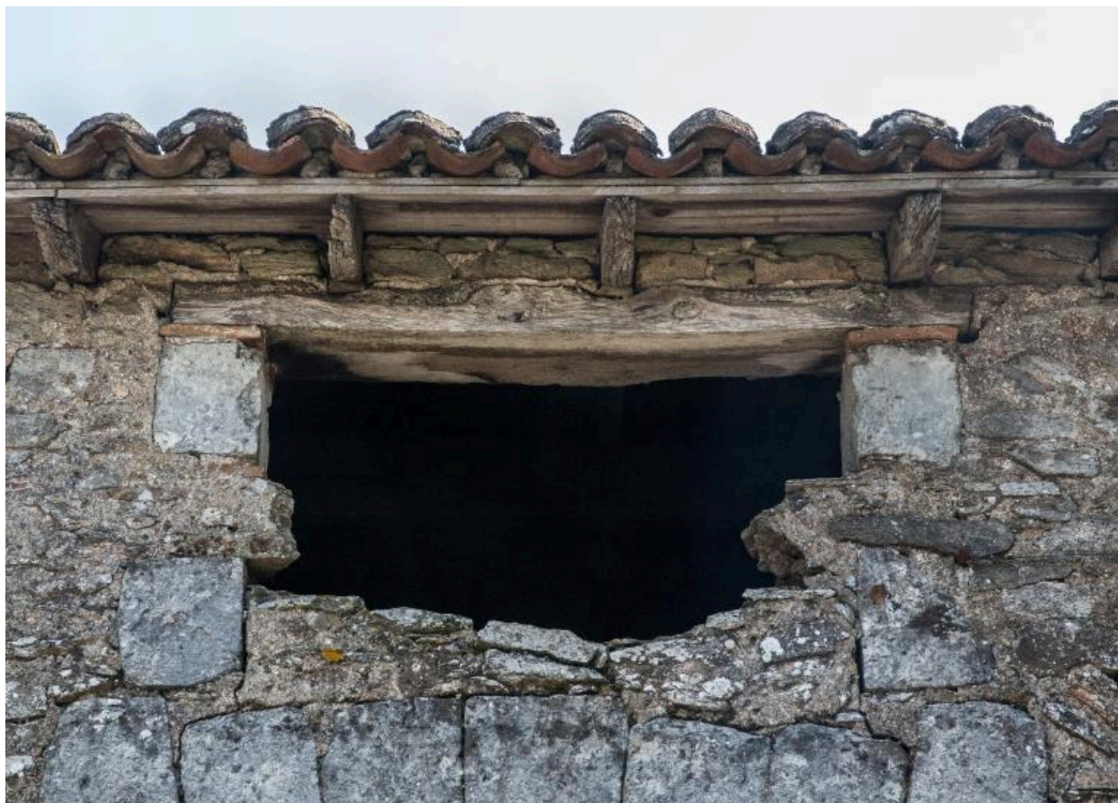
Débord de toit avec chevrons apparents et tuiles débordantes. Habitation. La Fennetière, Le Loroux-Bottereau. Cadastre 2018, BL 01-230
