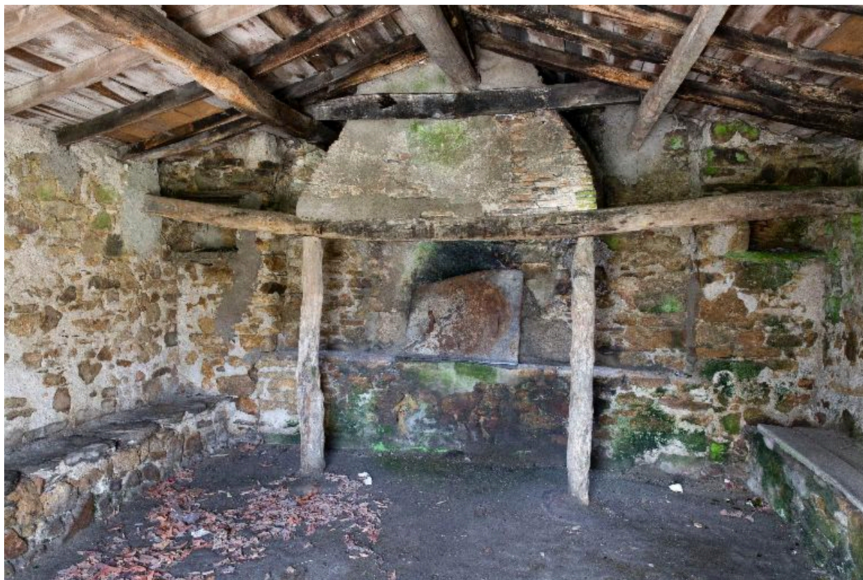
Four anciennement commun aux habitants de la Bretonnière (Maisdon-sur-Sèvre), vue intérieure du fournil, BY-68, cadastre 2018.
