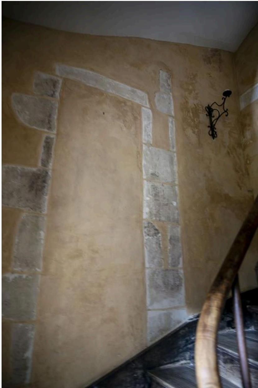
Des portes murées à l'étage de la tour.
