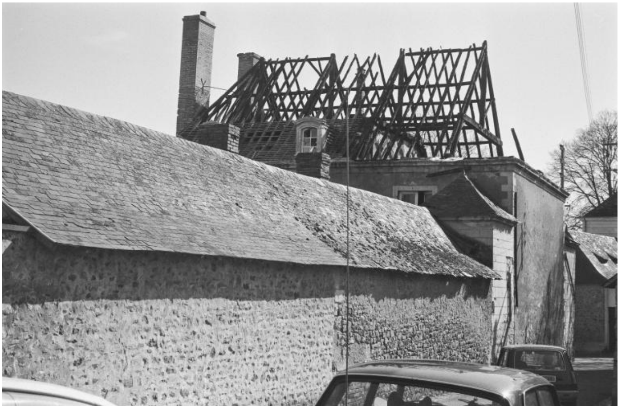
Façade est et côté nord.
