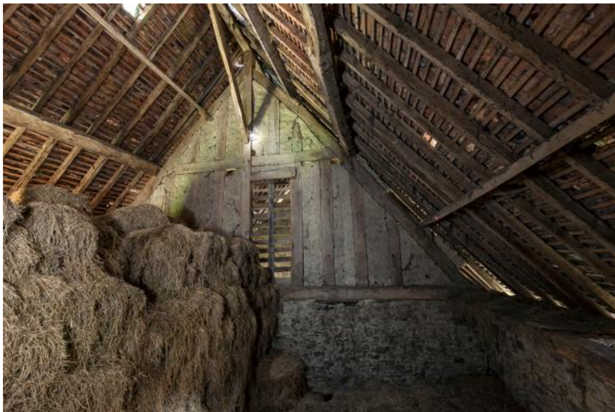
Ferme de charpente remplie de torchis en cloison de séparation, combles de l'alignement est
