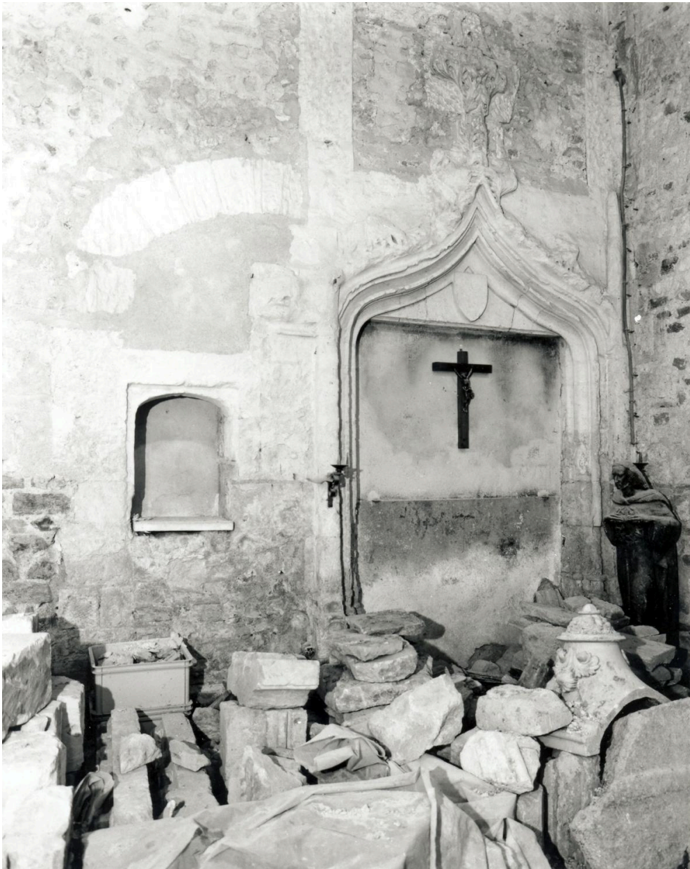
Collégiale Saint-Martin, croisillon nord du transept, face ouest : ancienne porte d'accès au cloître.
