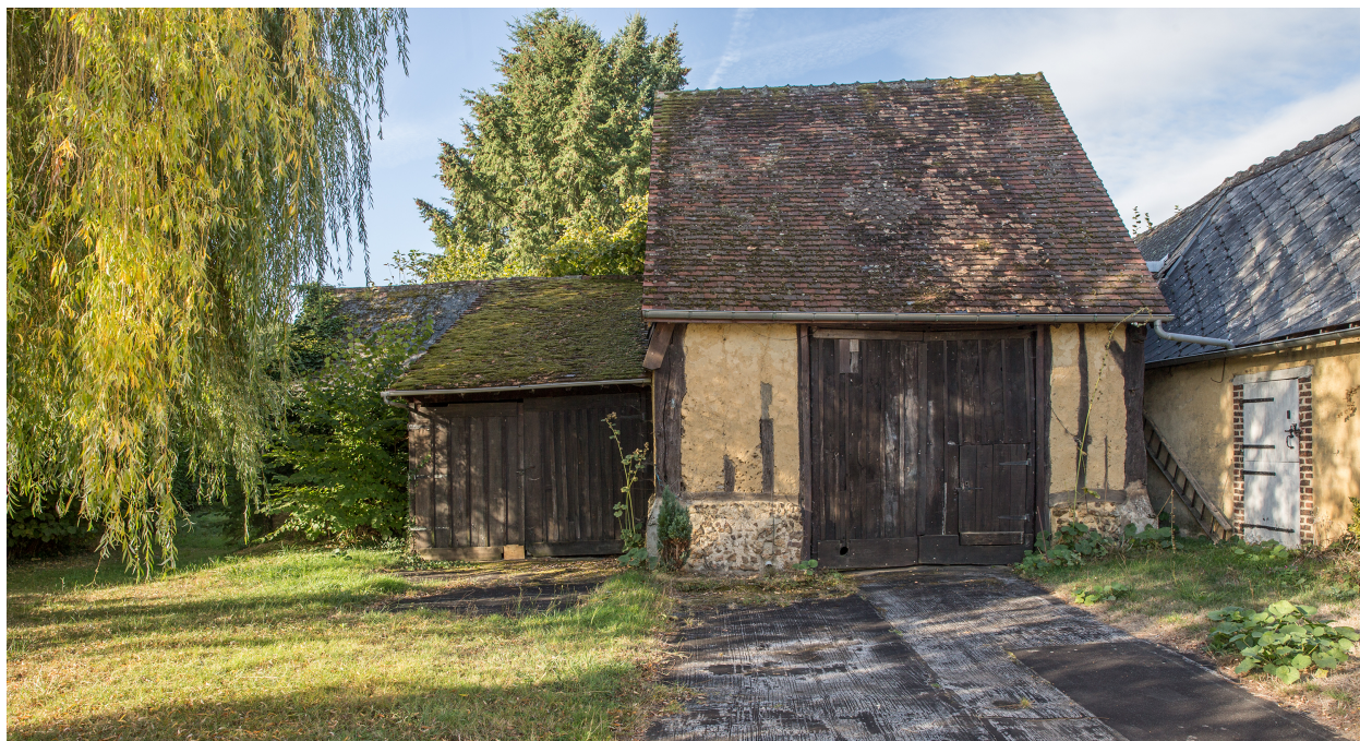
Une grange en pan de bois, début du XIXe siècle (?), rue des Sabotiers.
