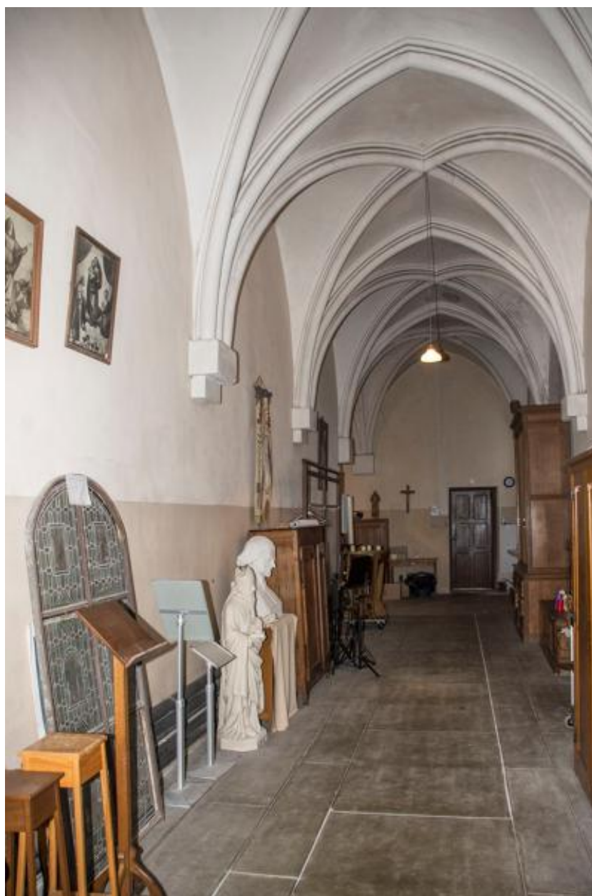
Galerie voûtée desservant la chapelle.
