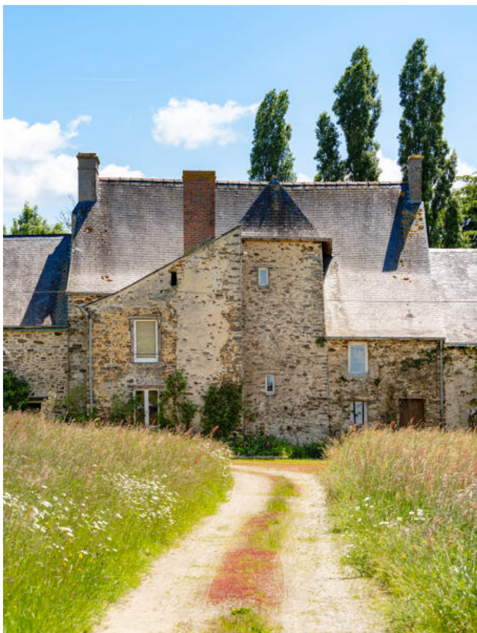
Le logis, élévation postérieure.
