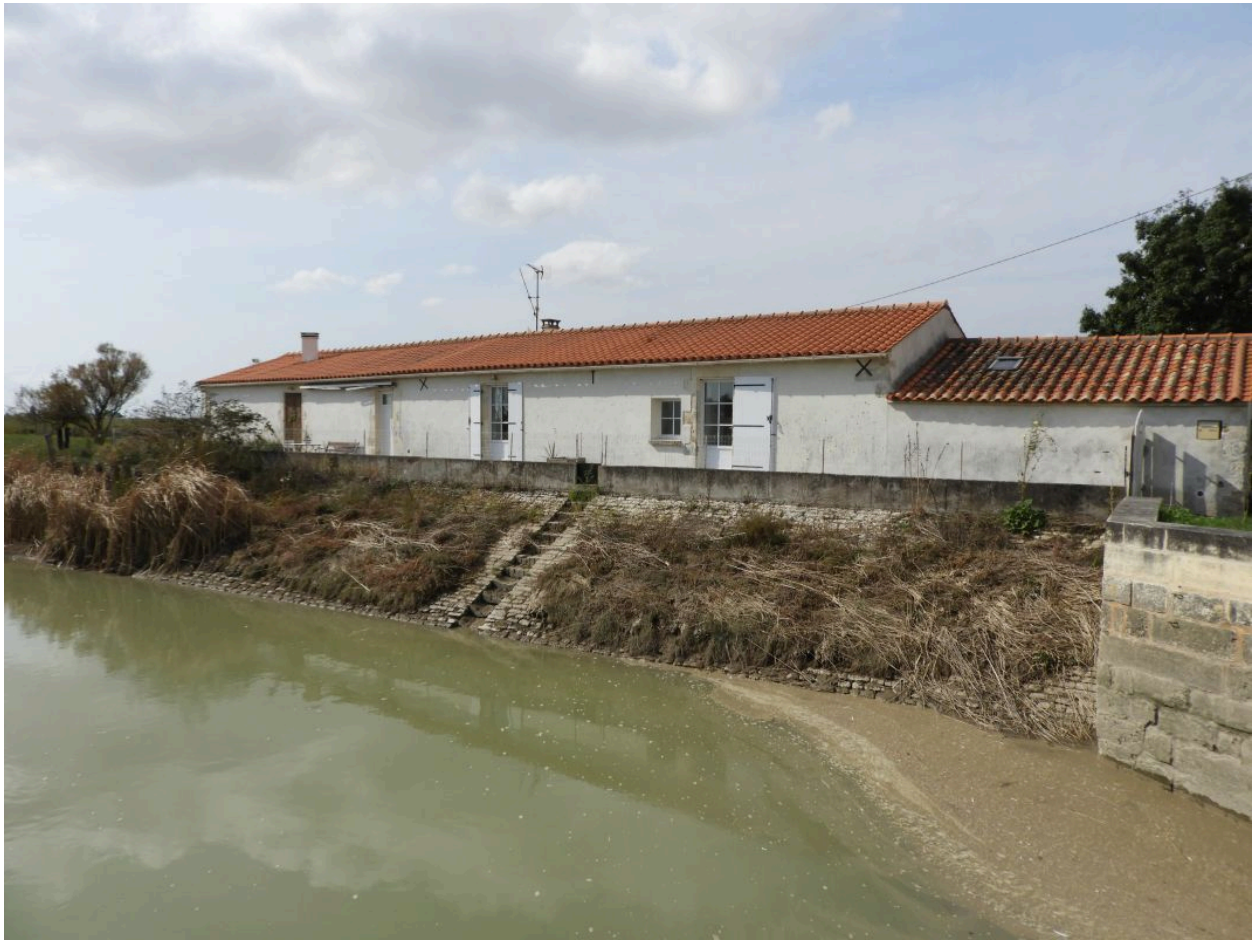
L'ancienne maison de garde de la porte, sur la rive droite du canal, en aval de la porte, vue depuis le nord.
