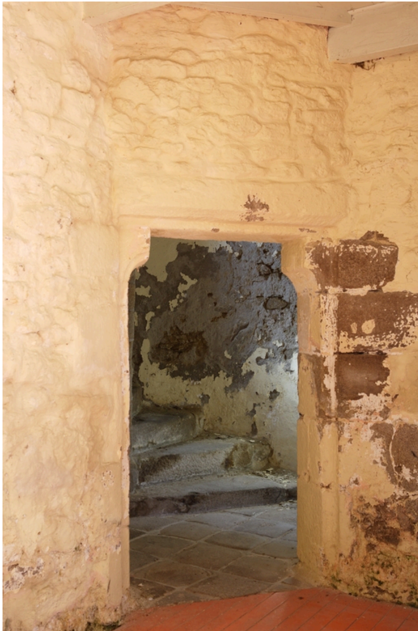
Tour d'escalier. Détail de la porte d'accès à l'aile sud.
