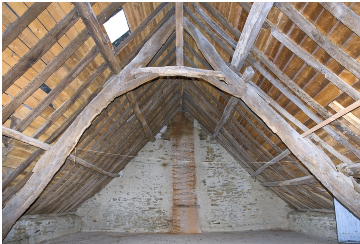
15 rue Jeanne-de-Navarre. Comble. Vue de la charpente.
