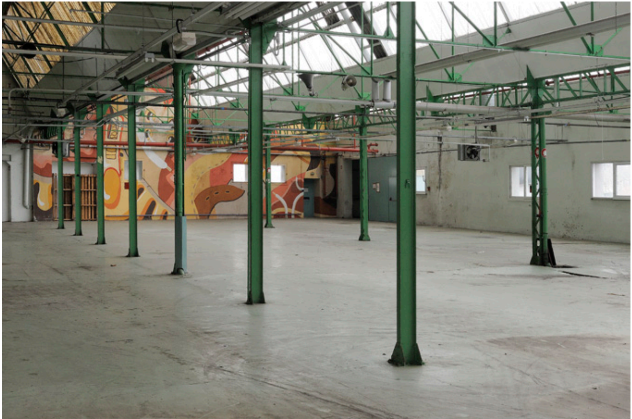
Atelier de l'usine Taïga (U1), situé dans la partie construite après l'incendie de 1932.
