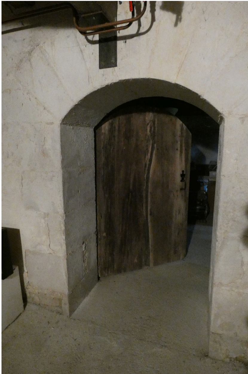
Porte entre deux pièces du sous-sol.
