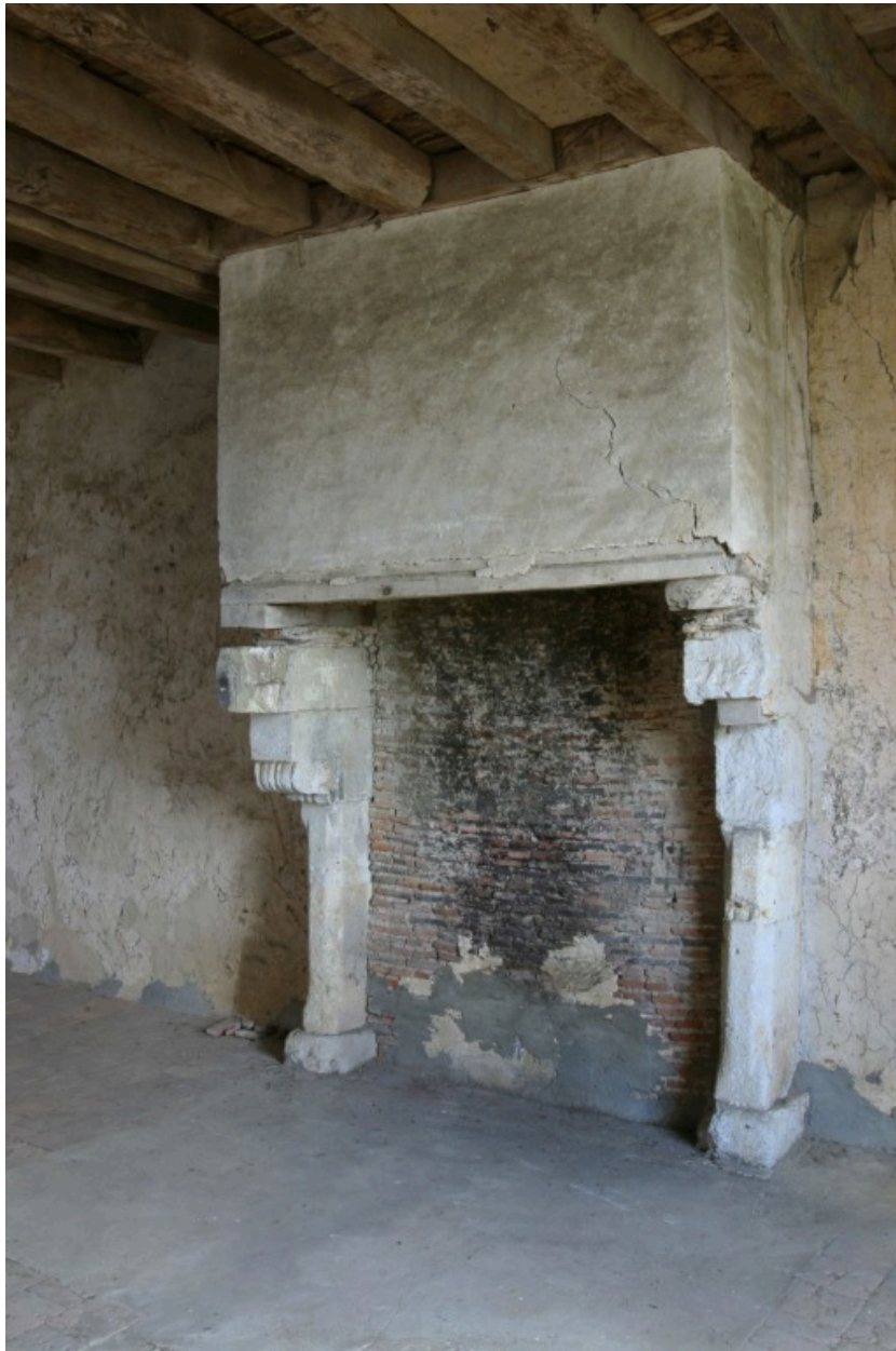
Rez-de-chaussée surélevé. Pièce 1B : la cheminée, située contre le mur nord.
