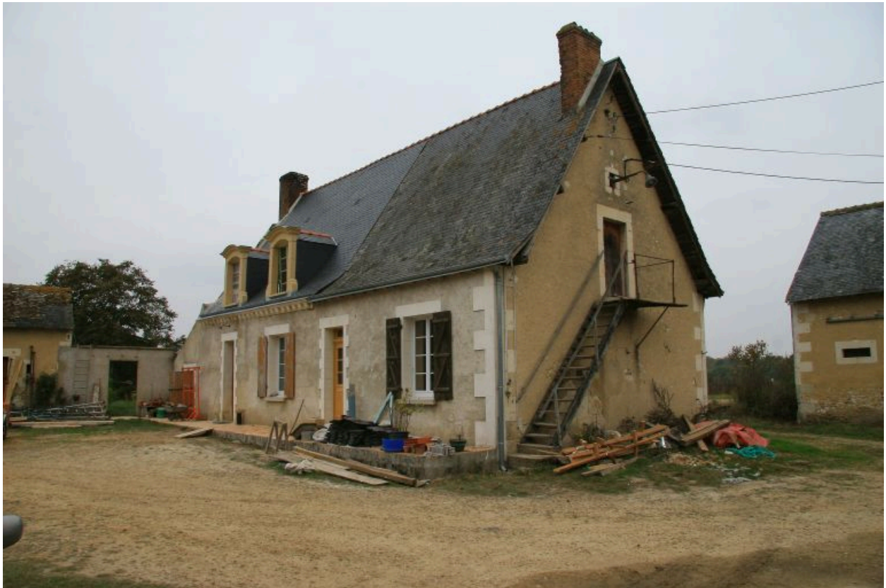
Vue de volume de la maison.
