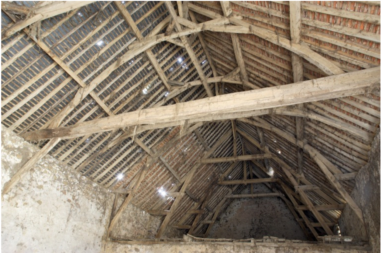
La charpente du corps nord vue depuis l'ouest.
