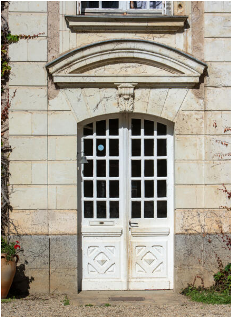
Le corps de logis principal, la porte d'entrée.
