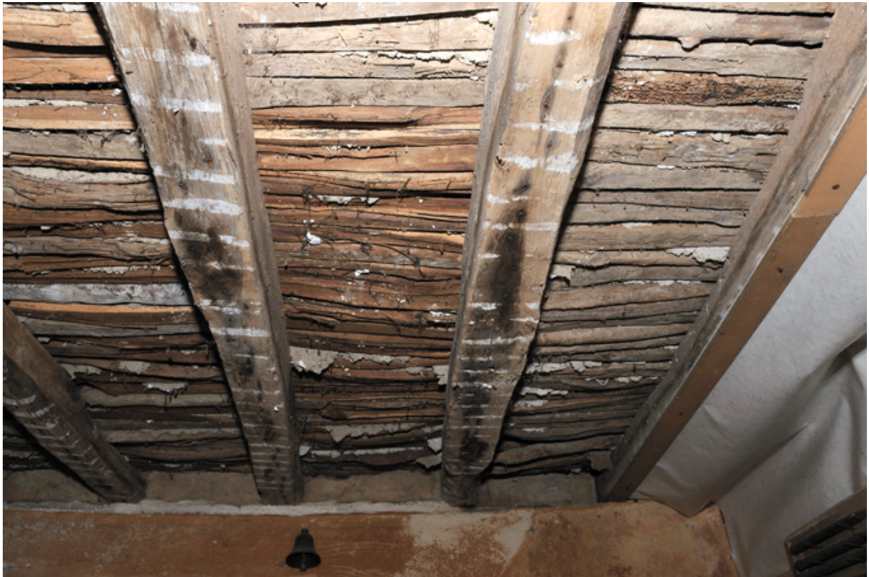
Aile sud, rez-de-chaussée : pafond en bouzillage.
