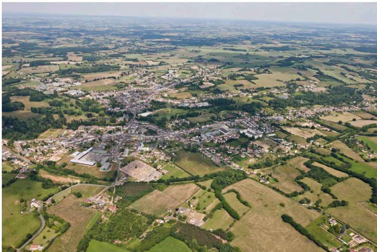
Vue aérienne générale depuis le sud.
