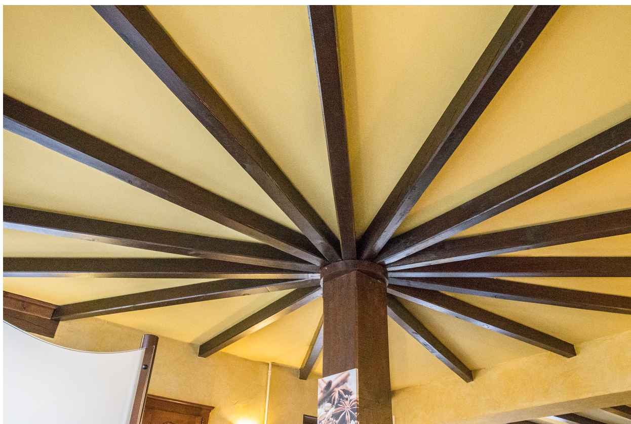
Le plafond de la salle de restaurant.
