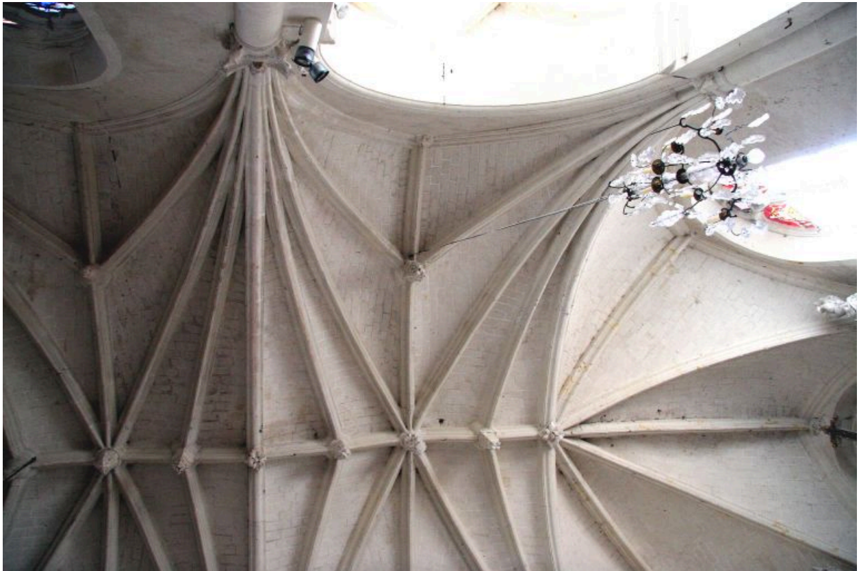
Demies travées de voûtes du chœur et l'abside.
