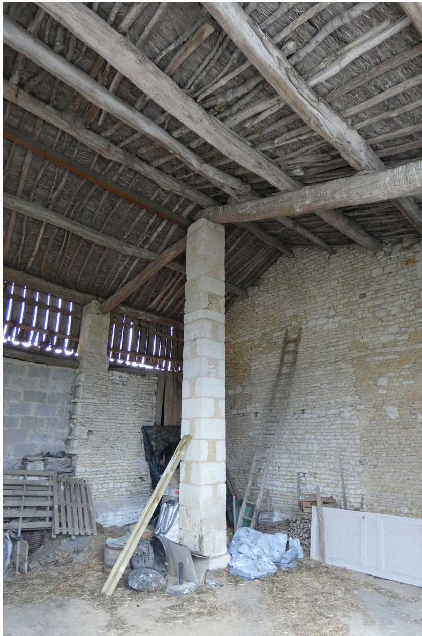
Le pilier en pierre soutenant la charpente et le toit du hangar.
