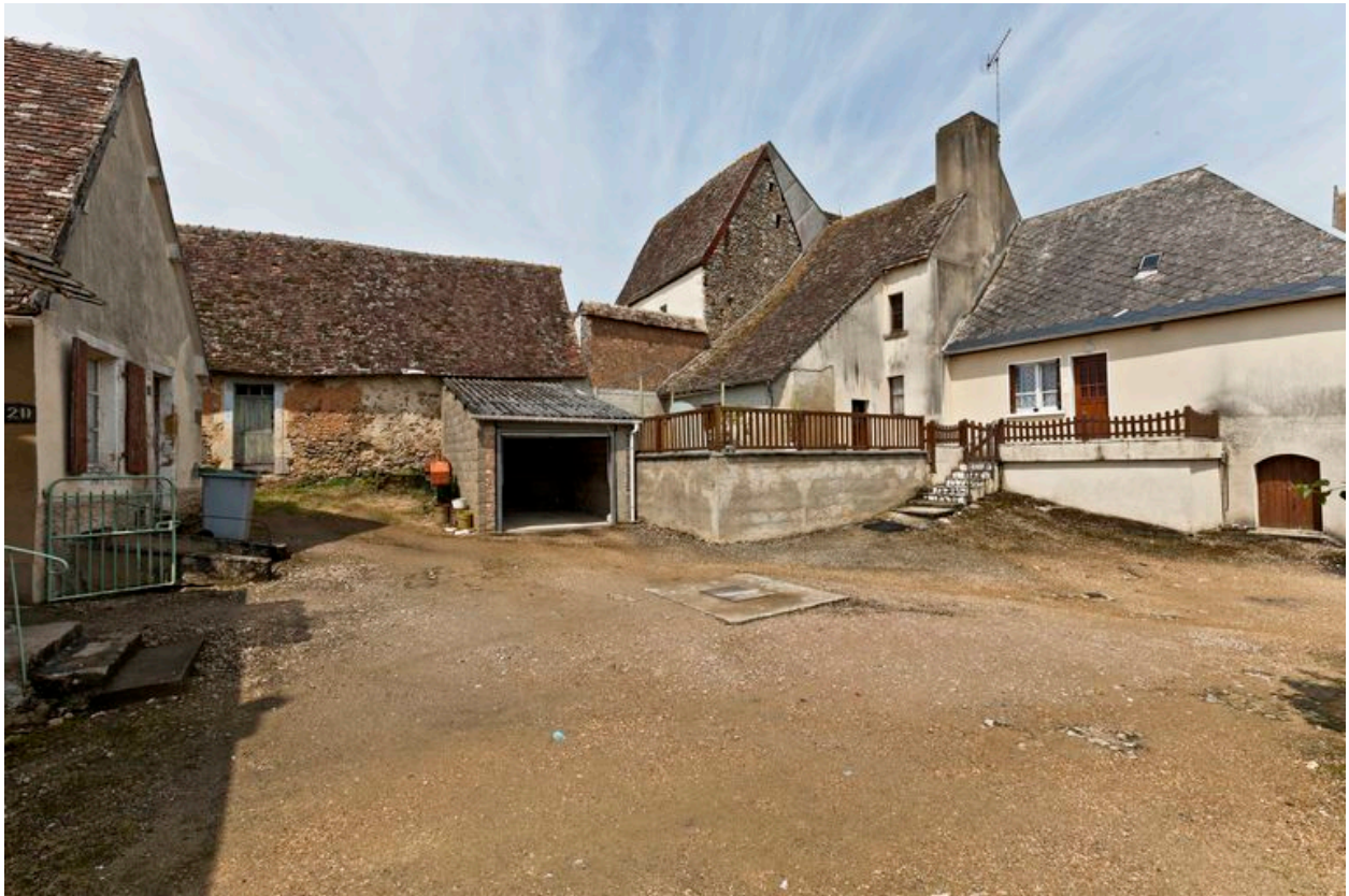
Vue depuis la rue des Murs (à l'arrière-plan).
