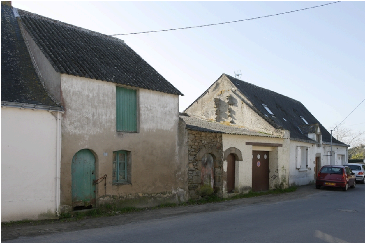
Vue d'ensemble des logis n° 27 à 31 rue du Rocher.
