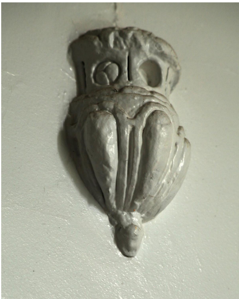
Rez-de-chaussée, voûte du vestibule : culot 3.
