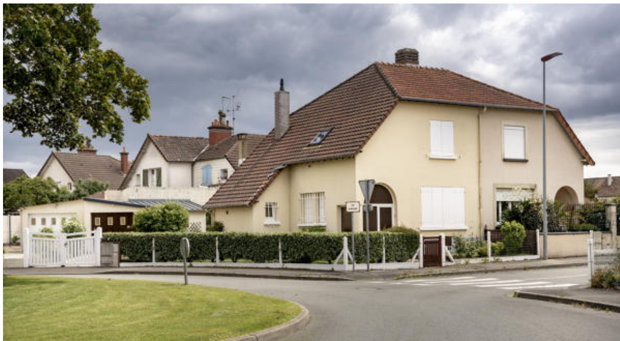
Vue de pavillons de différents type sur le square Paul Painlevé.
