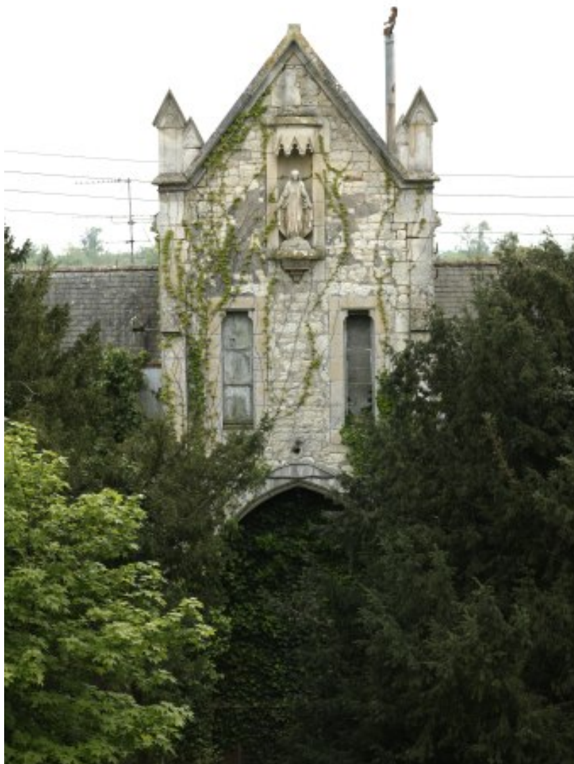
Façade sur cour du pavillon d'entrée : détail de la partie centrale.
