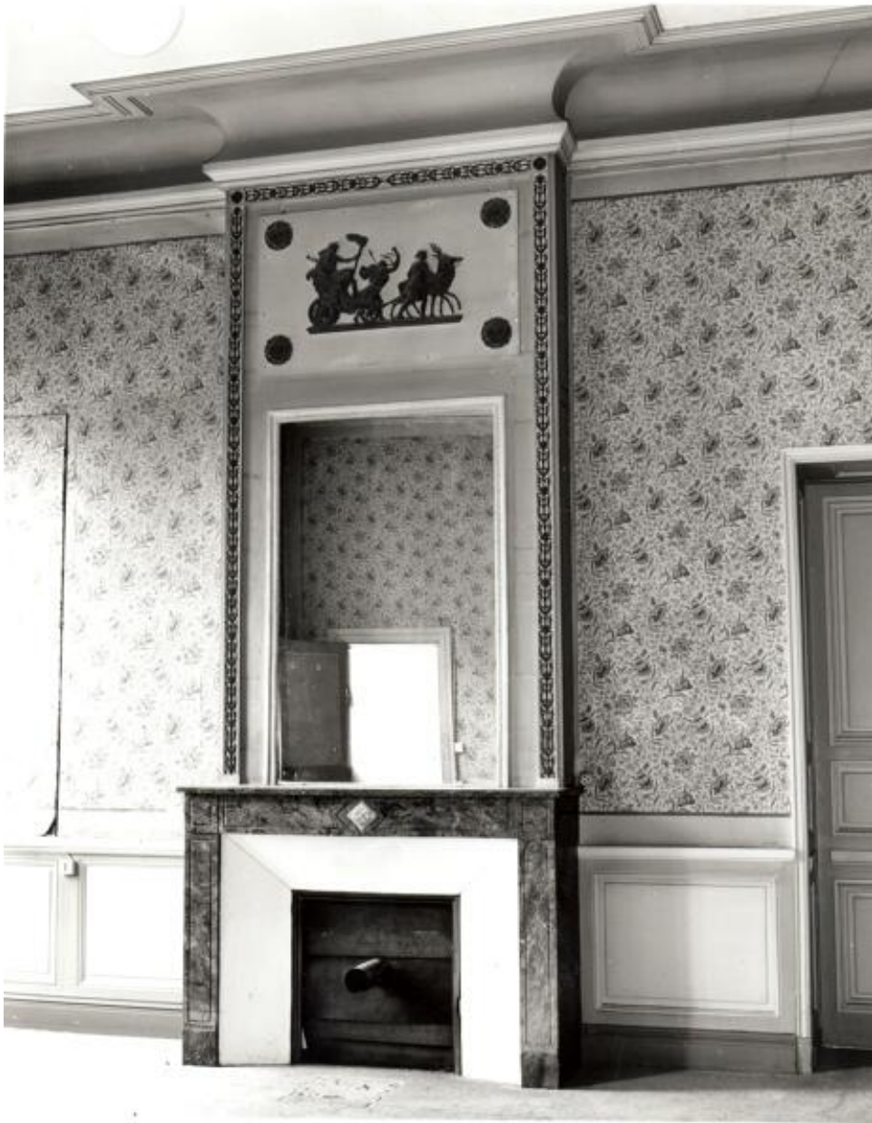
Corps principal, 1er étage, pièce médiane, mur gauche (est) : cheminée, vue d'ensemble.
