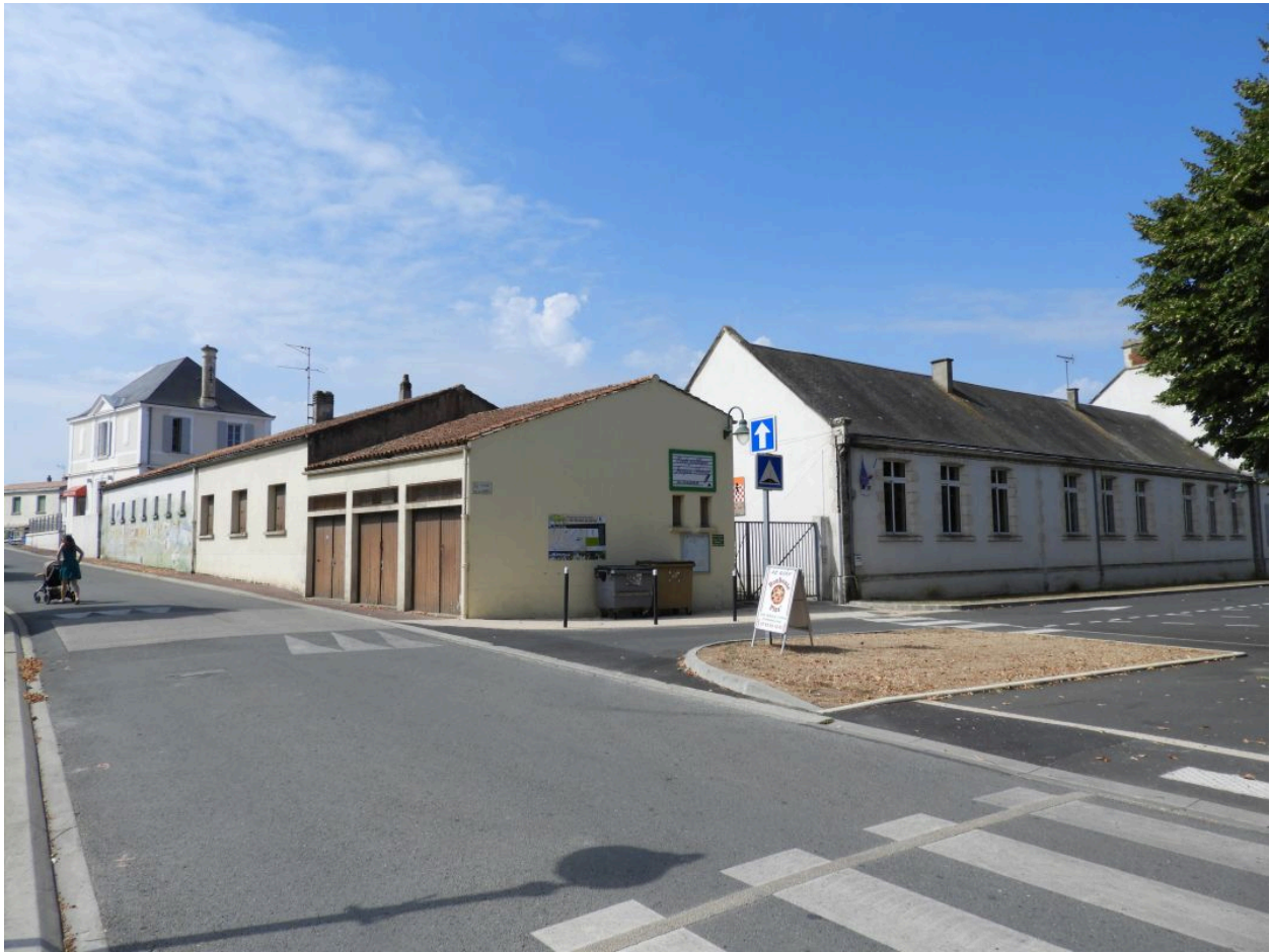
L'école vue depuis le nord-est. A droite, les bâtiments de 1887, à gauche ceux de 1964.
