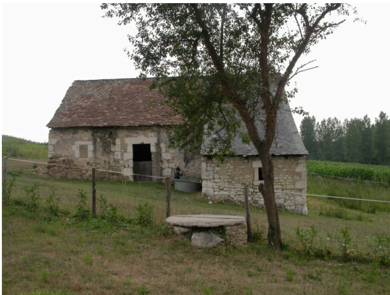
Façade principale : toit à porcsà gauche de l'entrée.
