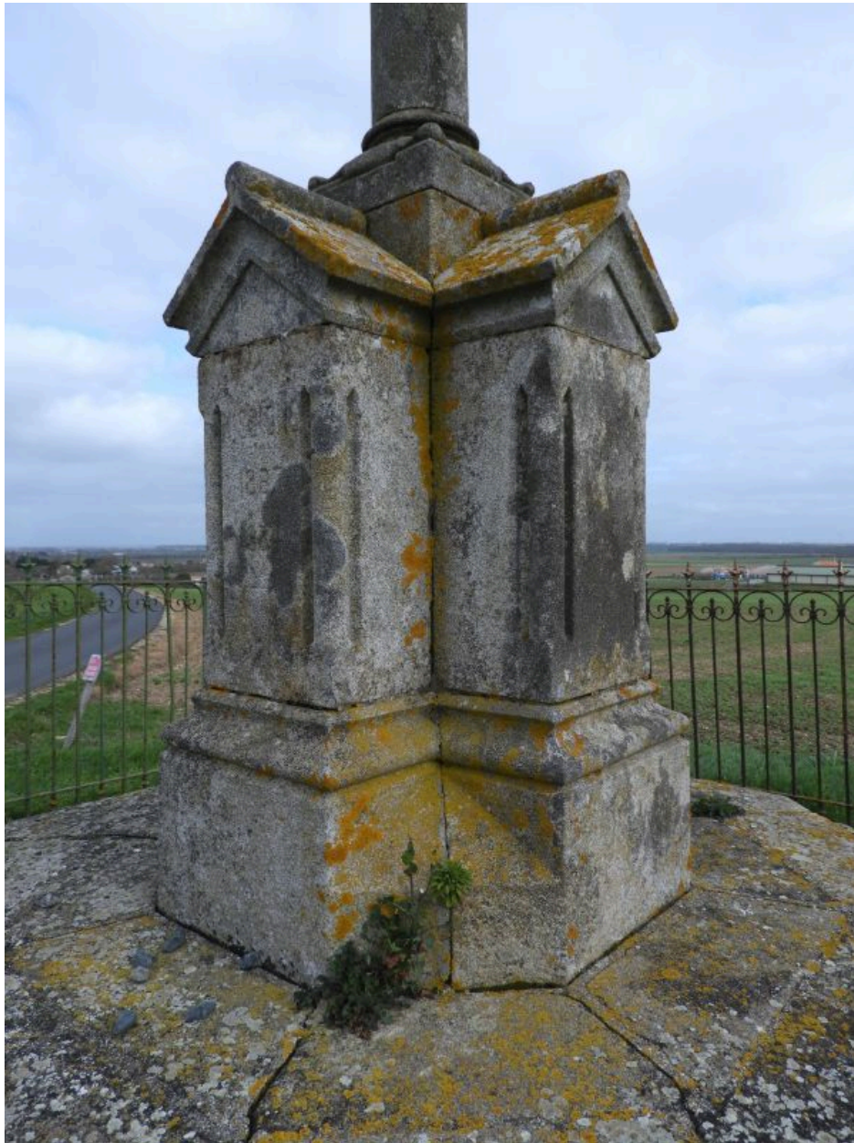
Le socle vu depuis le sud-ouest.
