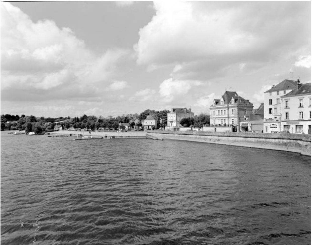
Le quai Pasteur et le port d'amont, sur la rive gauche, vus depuis le vieux pont.
