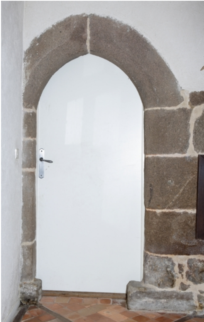
Rez-de-chaussée. Salle basse. Porte d'accès à la chambre froide.
