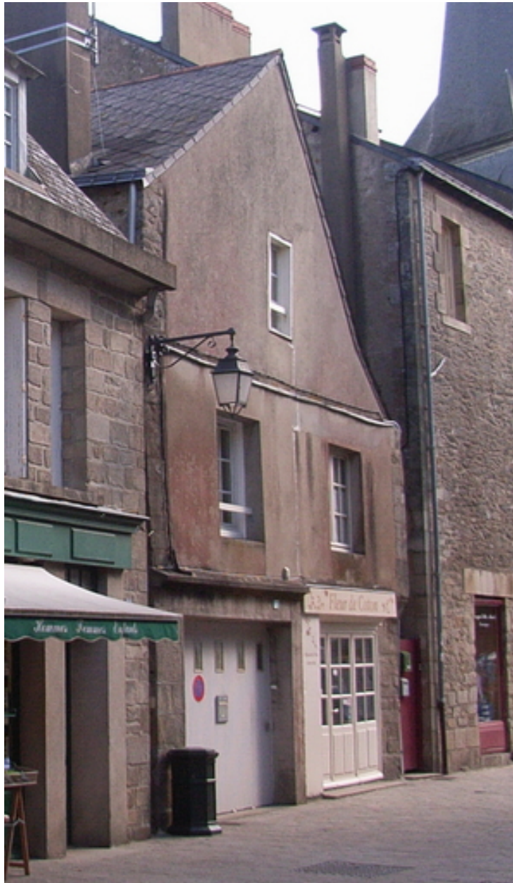
Vue de la façade à pignon sur rue.
