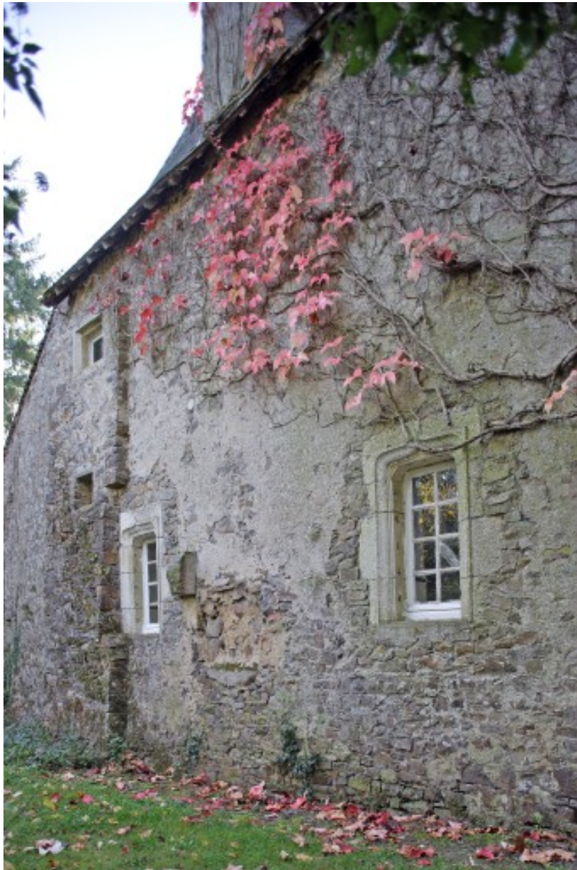
L'élévation latérale nord du pavillon vue depuis le nord-ouest.
