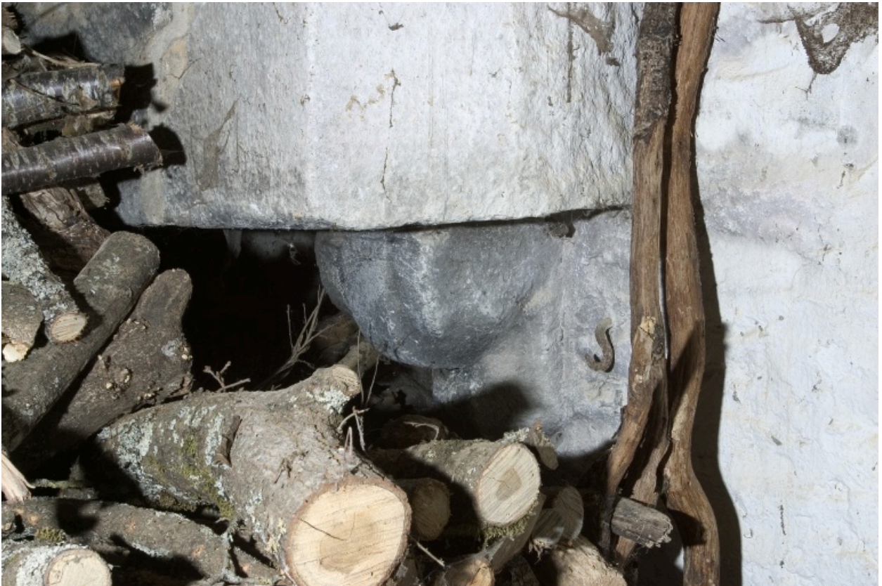
Intérieur de l'étable à chevaux-fournil : le corbeau droit de la cheminée du fournil.
