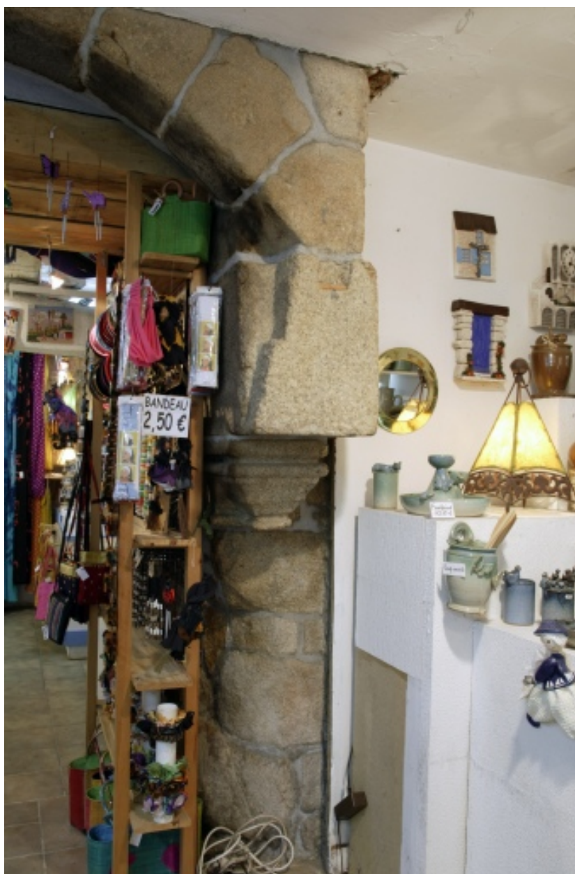
Cheminée, piédroit droit.
