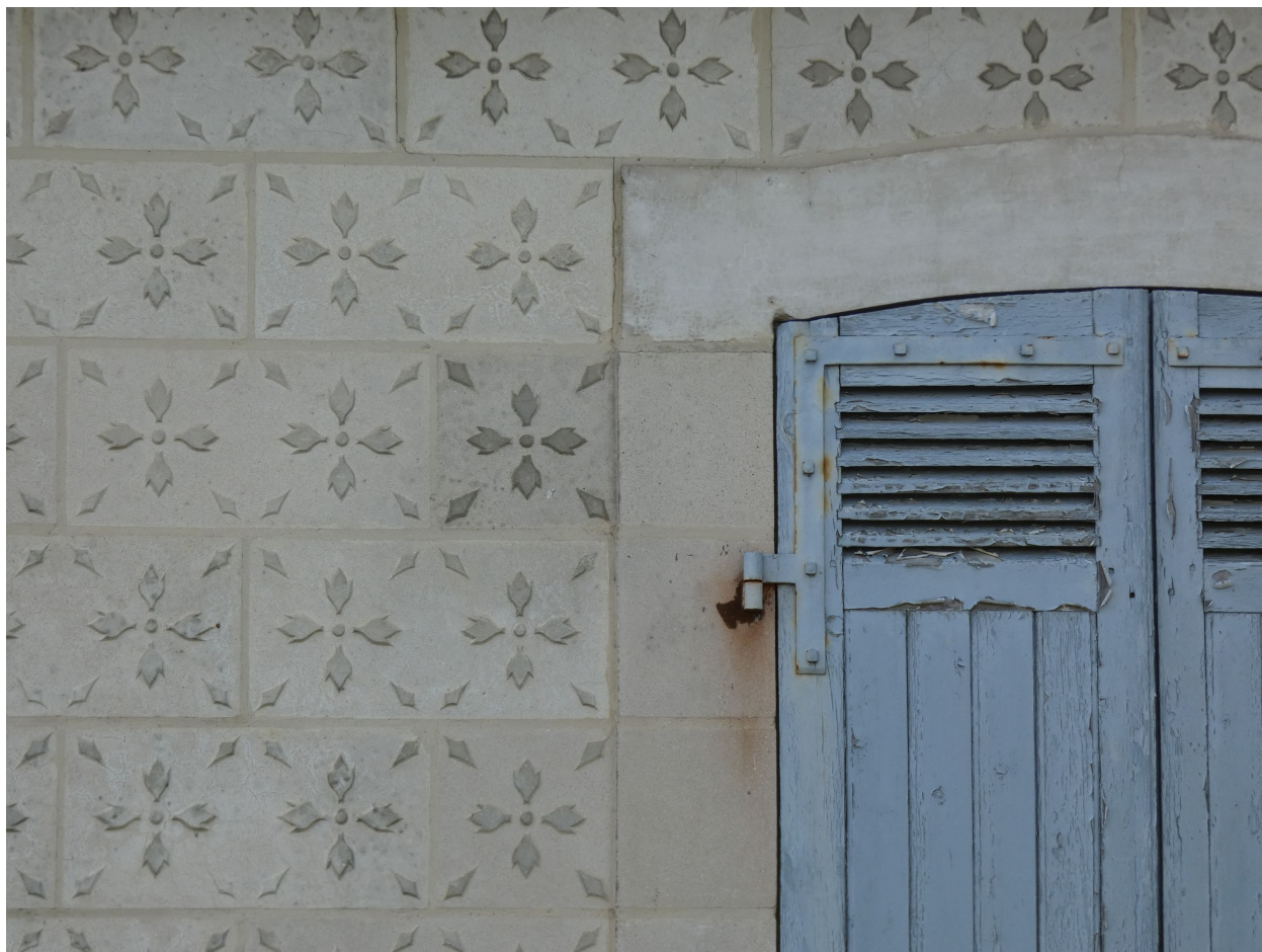
Détail du parement de l'extension ouest, avec son décor de croix.
