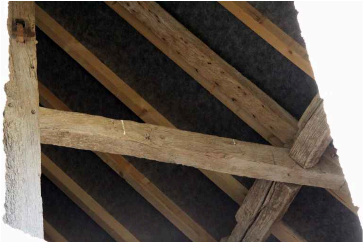
La maison n° 1 : charpente à pannes à encoche dans le faux entrait.
