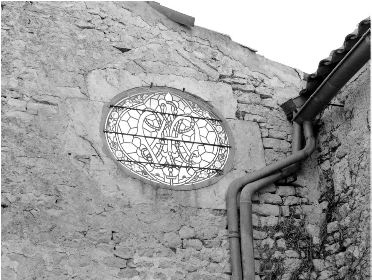
Verrière de l'oculus qui éclairait le bas-côté nord, vue depuis l'est au printemps 1974.
