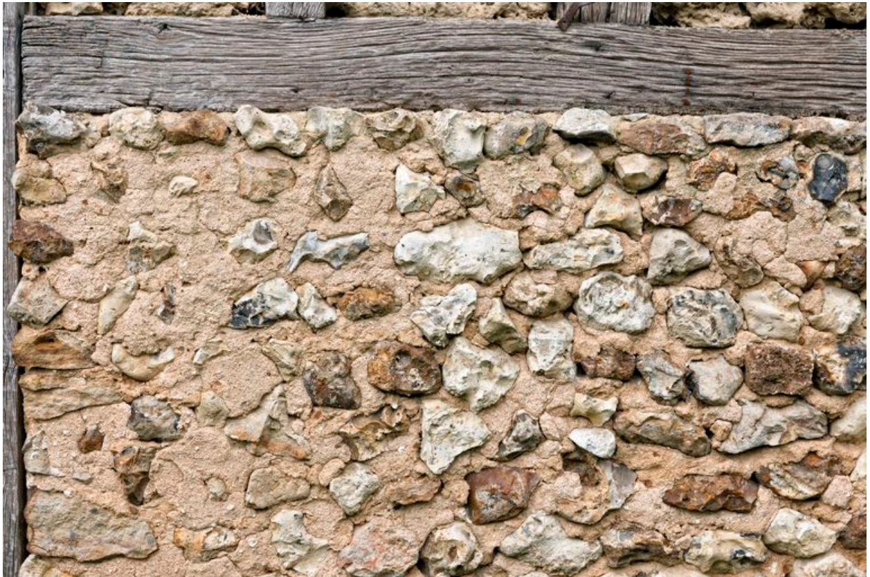
Détail de la maçonnerie du mur solin de la grange.
