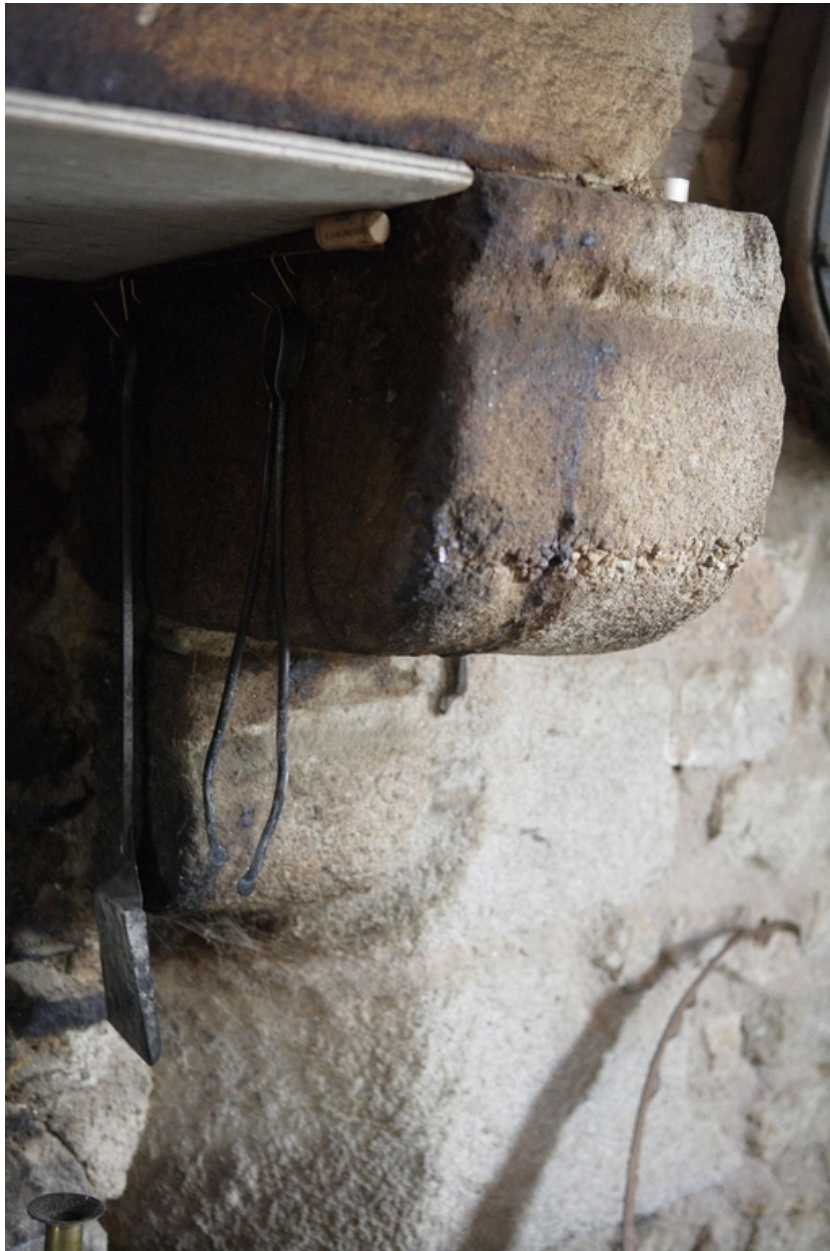
N° 10 rue du Rigouic. Détail du corbeau de droite de la cheminée (intérieur).
